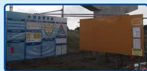
施工実績例写真
