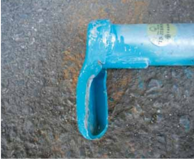
A-6 クサビ部分の変形、亀裂
