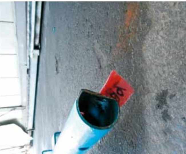
A-1 端部やジョイント部分の曲がり、変形
