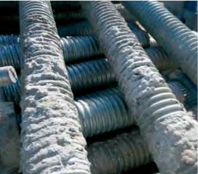
ネジ管部分のコンクリート付着
